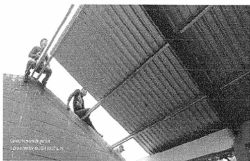
Foto1: Se observa el avance de las laminas portantes del modulo 1
