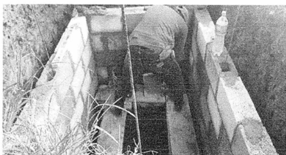
Foto 3: Se observa el avance de la fosa septica de los baños.
