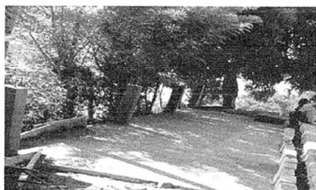
Foto 5: Se observa en el tortado y los postes de la cocina del modulo 3
